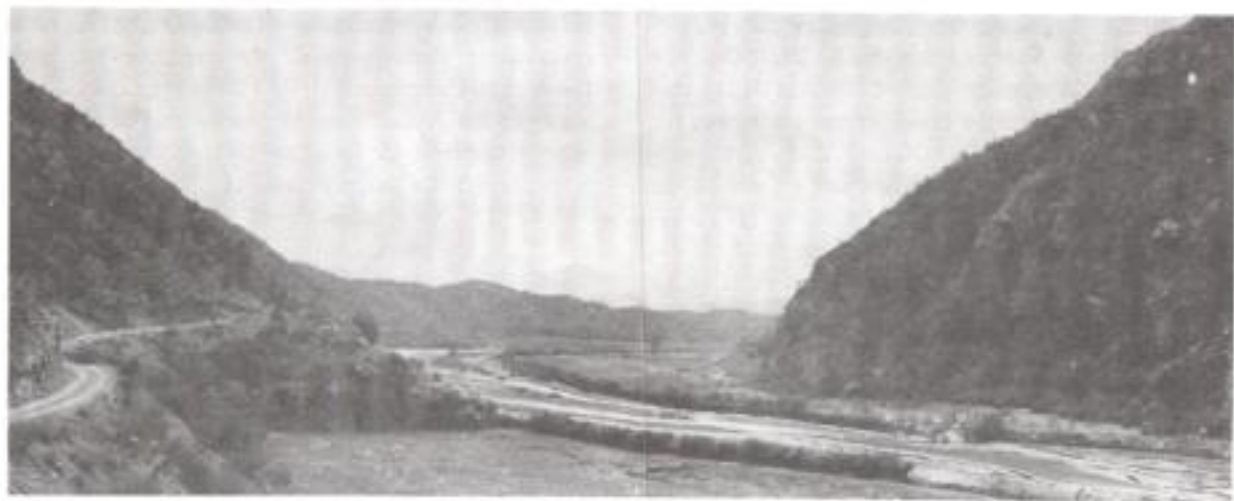
Localización de la Boquilla de Cahui a 3 Kms. aguas arriba de la ranchería Aurora, sitio posible para la construcción de una cortina, Río Sonora (1942).
